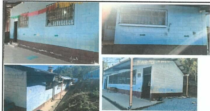
Foto 4: Mejoramiento de pintura para el edificio escolar.
