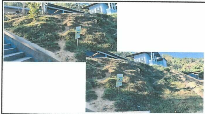
Foto 2: Mejoramiento Muro de contención.
