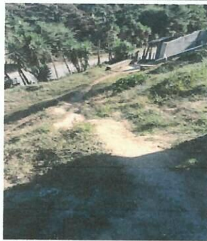
Foto 3: Mejormaiento de rampa en entrada principal del edificio.
